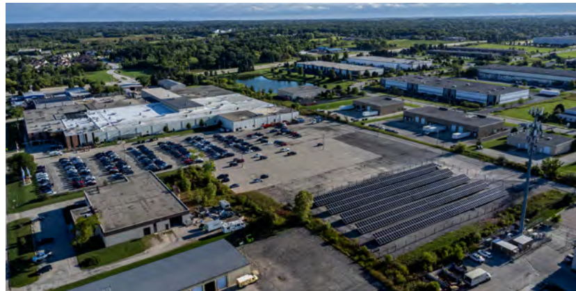
Erweiterung der Produktionsfläche auf dem bestehenden Campus in Franklin, Wisconsin
