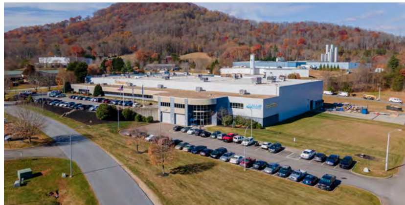
Anlagenerweiterung der Intralogistik in Arden, North Carolina
