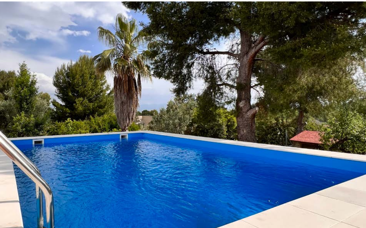
Pool mit gewebeverstärkter Schwimmbadfolie.
