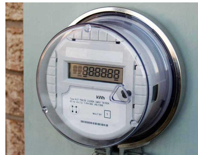
Zur Herstellung der digitalen Infrastruktur werden die konventionellen Zähler sukzessive durch digitale Zähler ersetzt.
